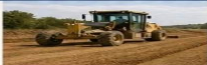
1. Alt Zemin Hazırlığı ve Sıkıştırma
