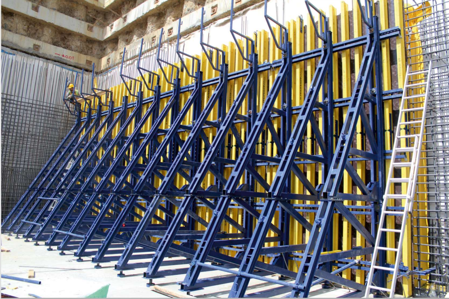
NURTEPE METRO İSTASYONU
