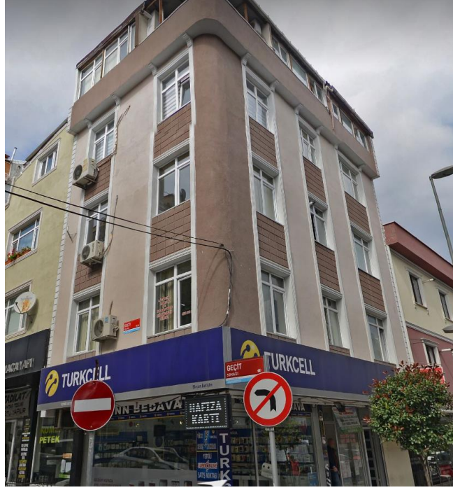
Farklı zamanlarda çekilmiş cephe görüntüleri 1
